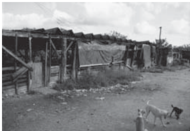
Fig. 1. Surto de Circovirose (SDMSD) no Estado do Rio de Janeiro. Extrema precariedade das instalações na propriedade onde ocorreu o surto. Outros animais eram criados juntos com os suínos. Ilha de Guaratiba, Rio de Janeiro.
